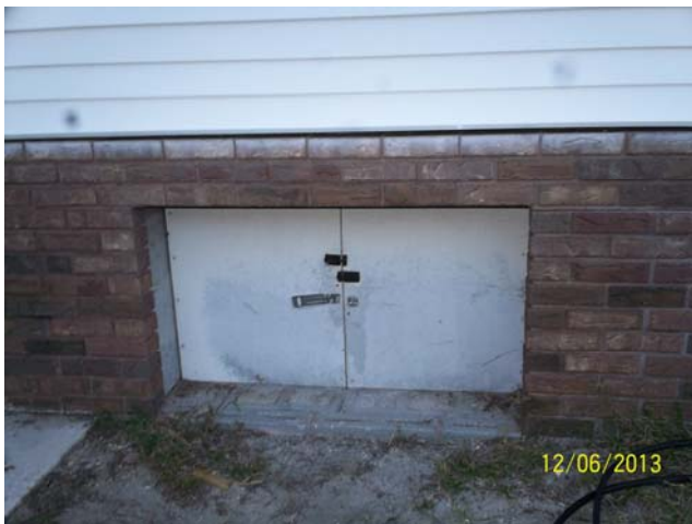
CRAWL SPACE DOOR
